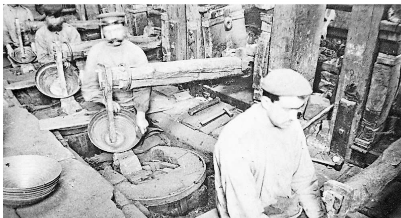
Das ehemalige Hammerwerk im Mühlengebäude des Untersten Hofes.
